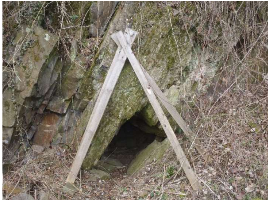
Firststollen Südportal zugänglich
