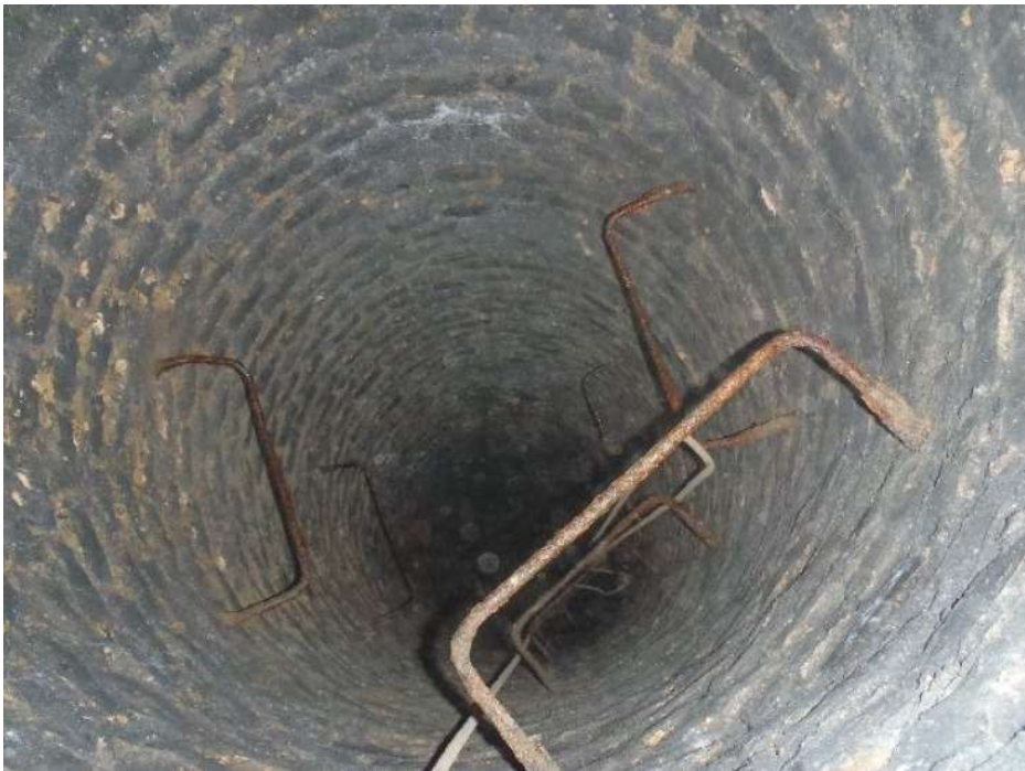
Ausmauerung: guter Zustand
