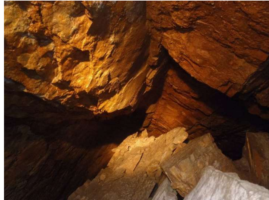
Firststollen Südportal: Bruchflächen
