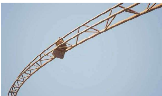
Bild 3: Detail des Ausbaubogens mit LOG 400
